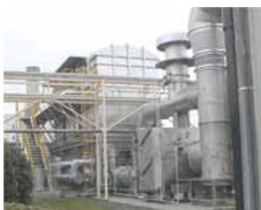
蓄熱燃焼式排ガス処理装置
