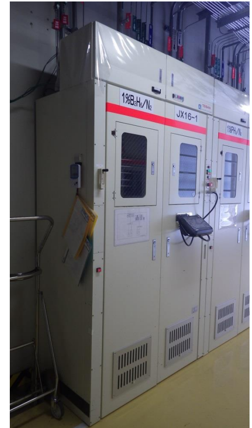
特殊材料ガスの シリンダーキャビネット (生産装置へ集中供給)
