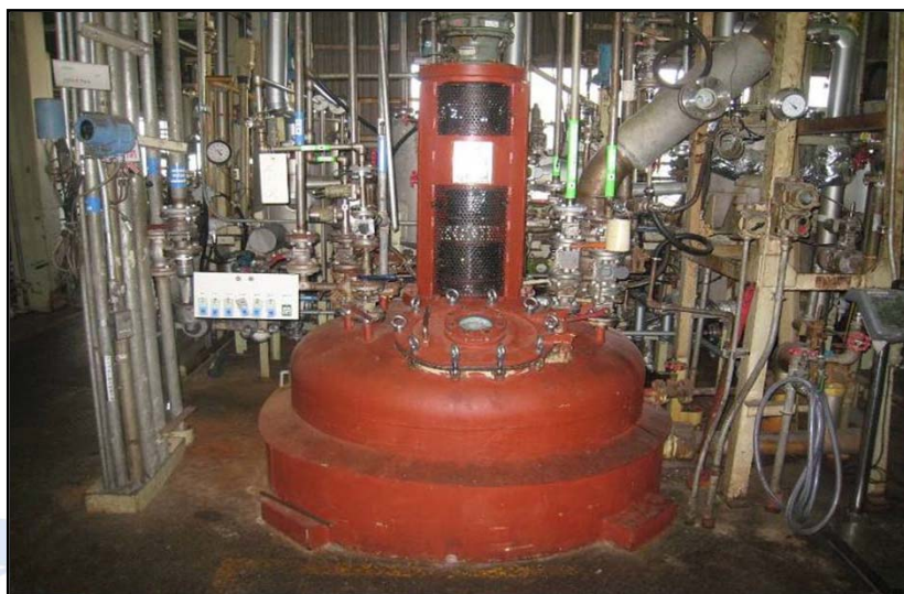
不具合を改善し塗料を塗装
