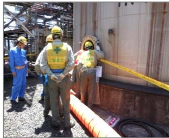
槽内作業の状況はどうか
