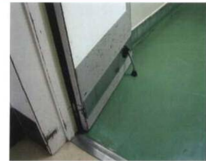
重い鉄扉の搬入口への ストッパー設置
