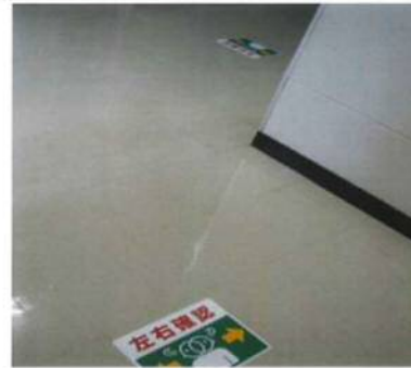
廊下の曲がり角の 床面への注意喚起シール 貼付による衝突防止
