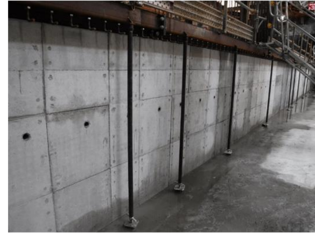
コンクリート型枠
