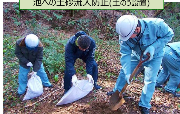
池への土砂流入防止(土のう設置)
