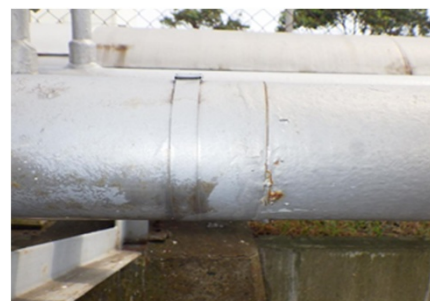
ケレンで塗装、錆落とし、腐食深さ測定
