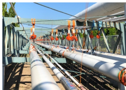
吊り上げて架構接触部の腐食確認
