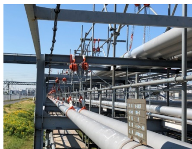
吊り上げて架構接触部の腐食確認
