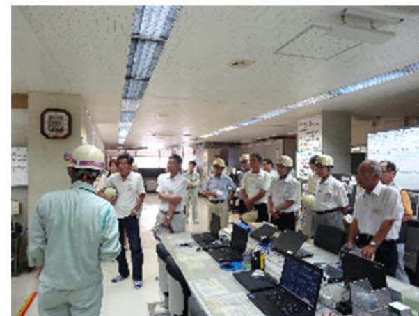
コントロール室視察
