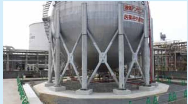
球形タンクの耐震補強
