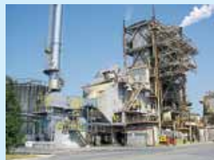
ばいじん防止設備
