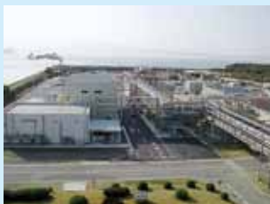
排水処理設備
