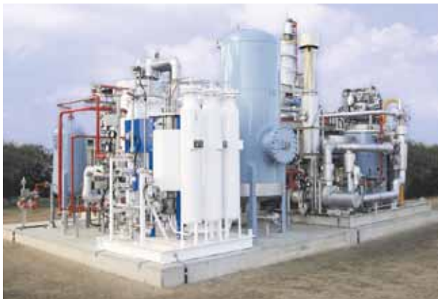
水素製造装置(メタノールから水素を製造)
