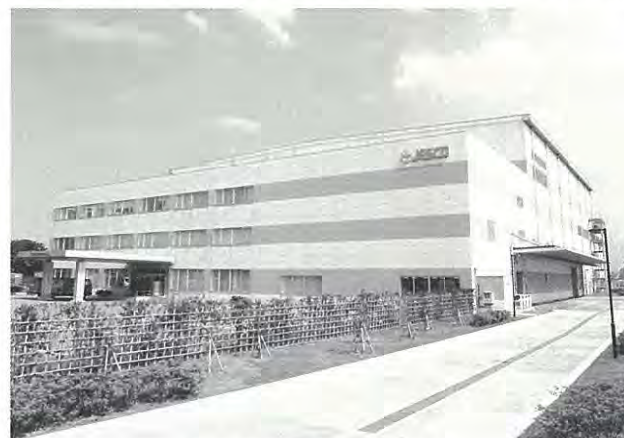
北九州 PCB 廃棄物処理施設 (日本環境安全事業株式会社 北九州事業所)
