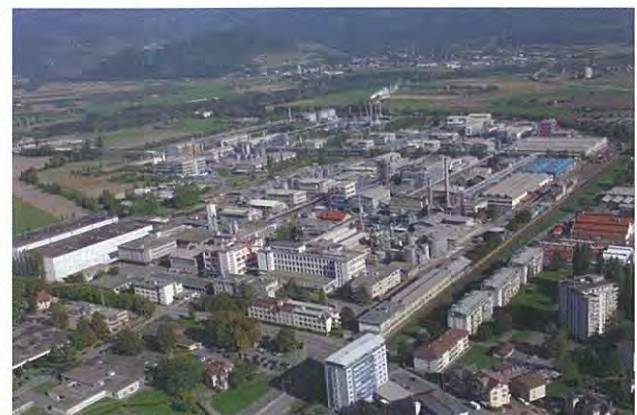
スイス・モンテ工場：地域の下水処理を工場の施設で行うなど、コミュニティ全体の環境管理に寄与している。
