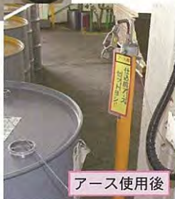
【光り物】静電気除去用アース線。使用後クリップを離すとアース線がポスト内に収納される。
