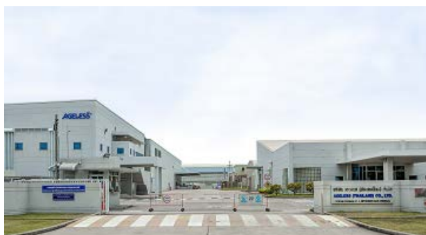
タイ工場の外観
