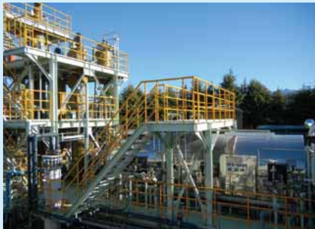
排ガス焼却炉
