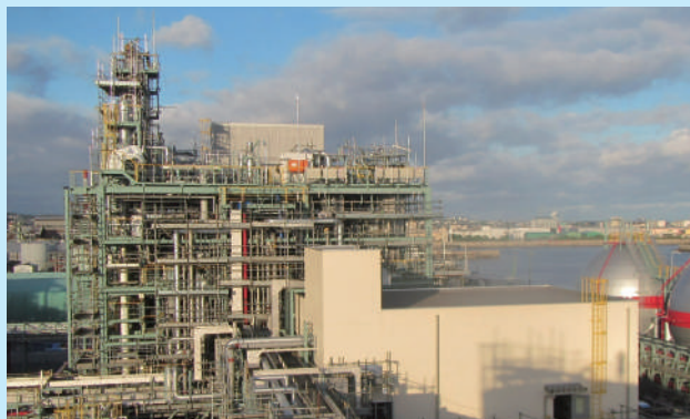
環境配慮型ノンフロン製品製造プラント
