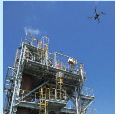
ドローンによる点検
