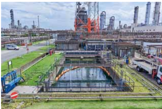
千葉工場の廃水処理設備
