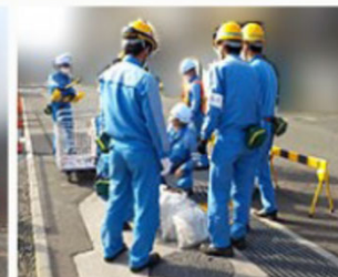
B機動班： 土嚢積み
