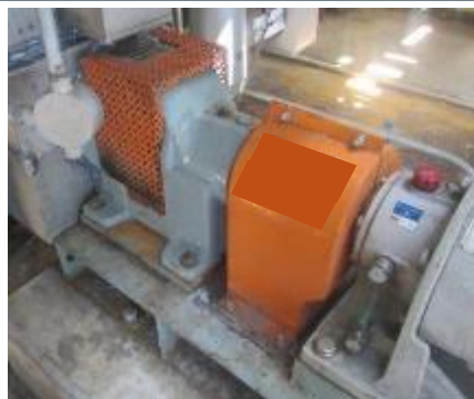
ポンプ駆動軸の保護カバー
