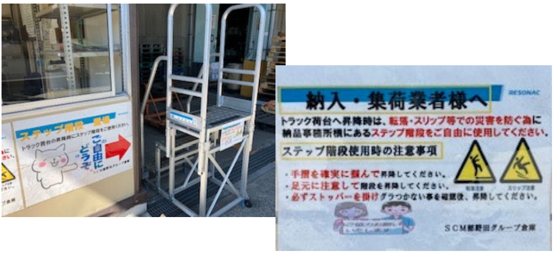
納入・集荷時のトラック荷台昇降ステップ台設置 荷台からの転落防止用に業者が活用
