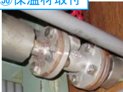
③⑩保温材取付
