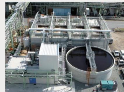
活性汚泥処理設備は、工場排水を無害化処理することによって海や河川の汚染を防止します。
