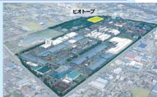
工場敷地とビオトープの立地
