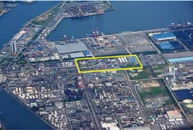
コンビナート内の四日市工場
